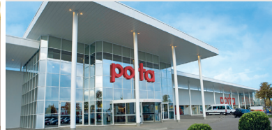
32457 Porta Westfalica • porta Möbel Handels GmbH & Co. KG Barkhausen Feldstraße 20
